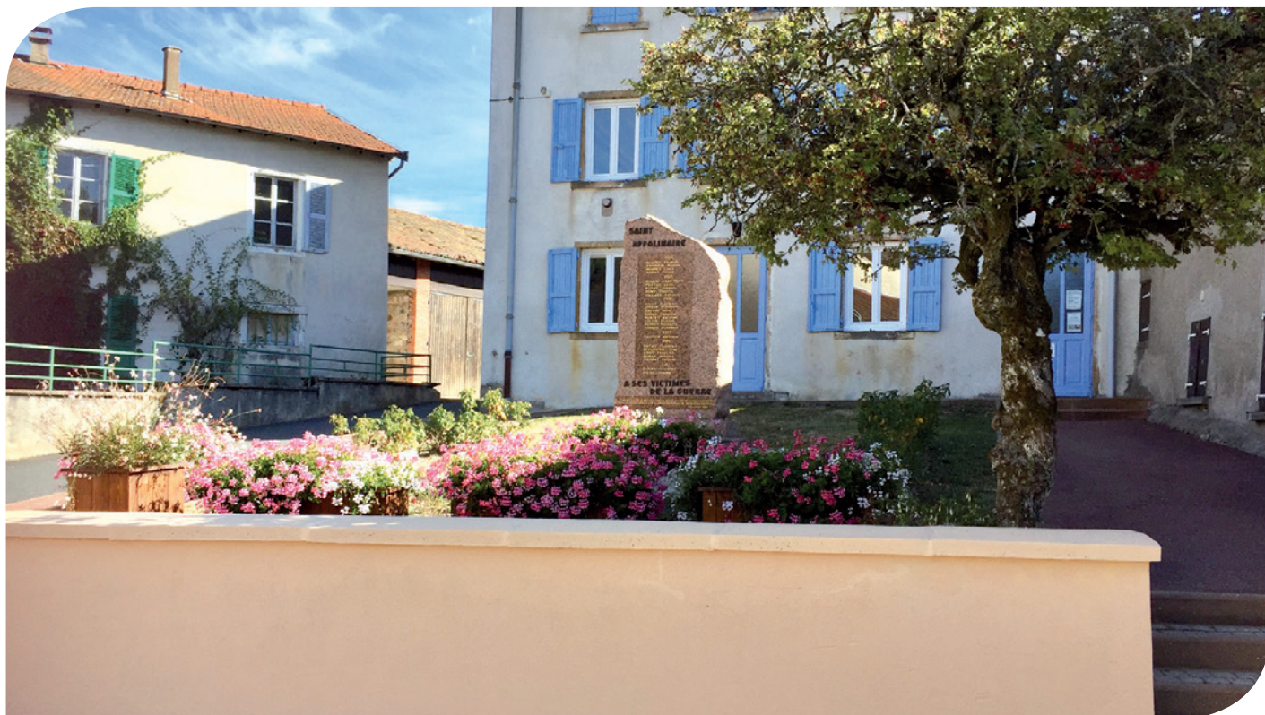
Rénovation du mur de la mairie
