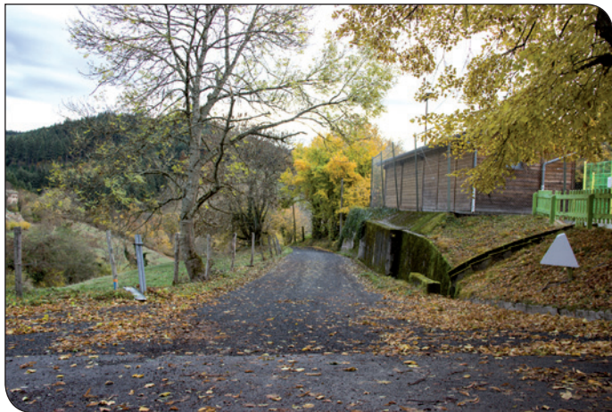
Réfection du chemin des Bruyères
